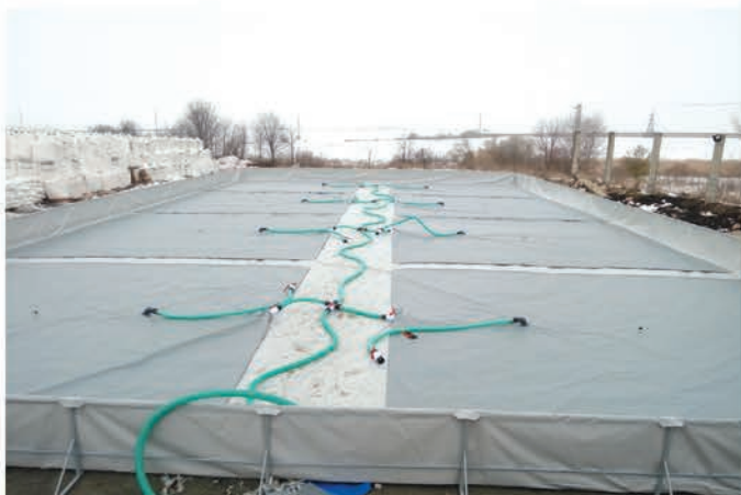
Резервуарный парк для КАС на 800 м 3
