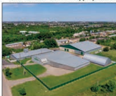
Площадь производственных и складских помещений ООО «СибАгроЦентр» более 5000 кв.м. Работают две семенные линии с оптическими сортировщиками.
